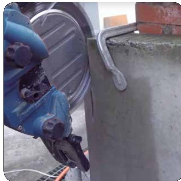
Geleiderol houdt het blad stabiel en centraal bij de zaagaanzet.
